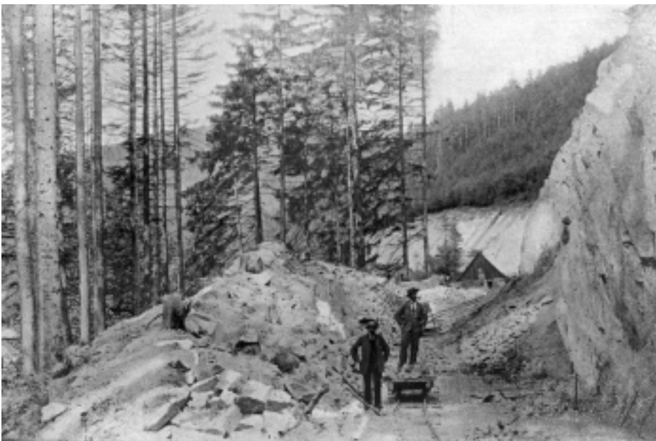
Výkopové práce v žele u Merklína (trať Dalovice – Merklín, v provozu od roku 1902).
